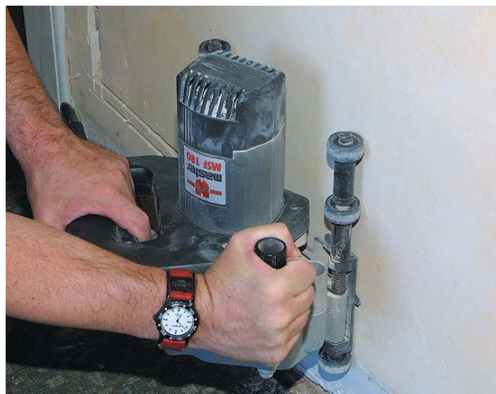
Vízszintes horony marása.
